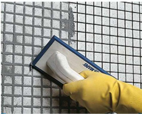
Remplissage des joints entre carreaux de pâte de verre à la spatule, dans une salle de bains
